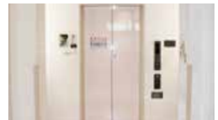
本館のエレベータ (緊急用)
